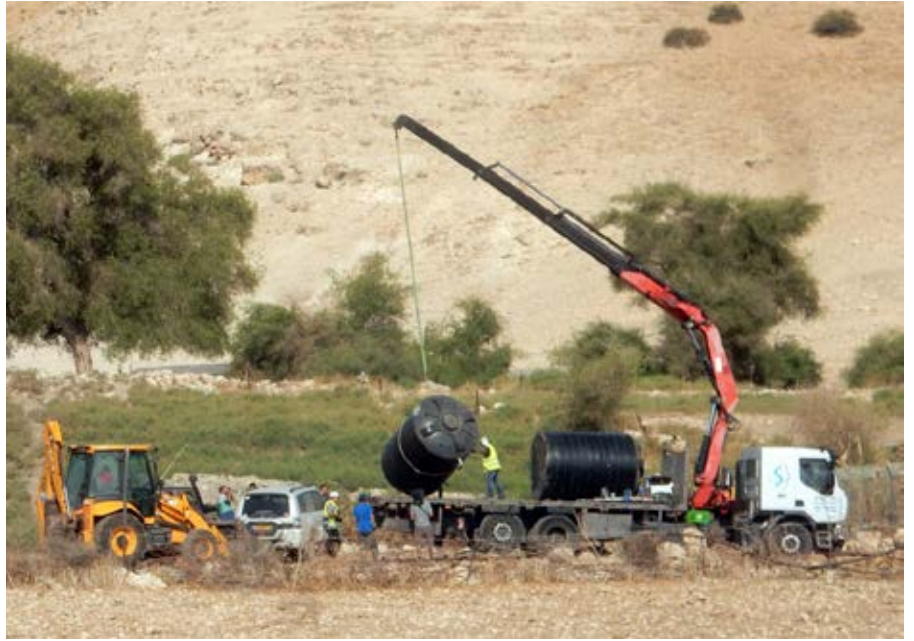
"الإدارة المدنية" تصادر صهاريج مياه في خربة تل الحمة
